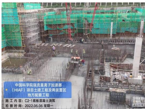
中国科学院强流重离子加速器 (HIAF) 项目土建工程及两装置区地方配套工程 施工内容: B1-2顶板混凝土浇筑 拍摄时间: 2022.06.06 星期一
